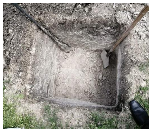
Figura 5. Calicata de material arcilloso
