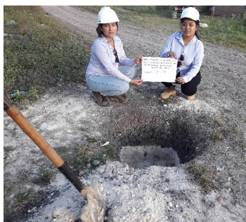
Figura 4. Excavación manual de la calicata
