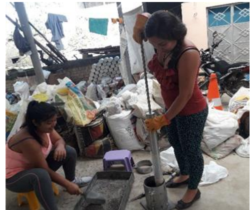
Figura 22. Compactación del material preparado
