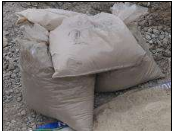
Imagen 31. Finos almacenados para evitar su contaminación
