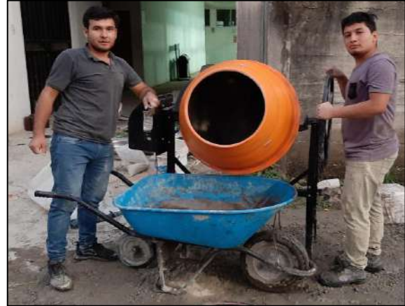
Imagen 33. Elaboración de concreto por medio de mezcladora
