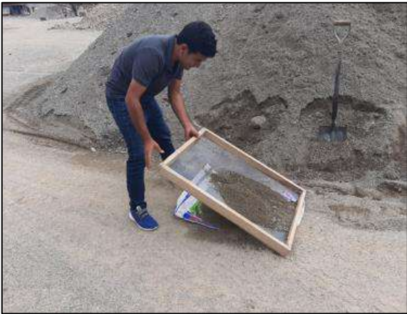
Imagen 28. Recolección y zarandeado de material fino en la contera
