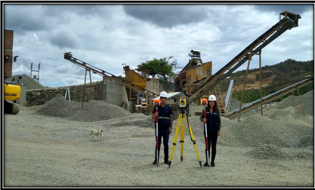
Foto N° 04: En la imagen se visualiza el trabajo en campo de topografía con Estación total en la planta chancadora de cantera Santa Rosa Fuente: Elaboración propia
