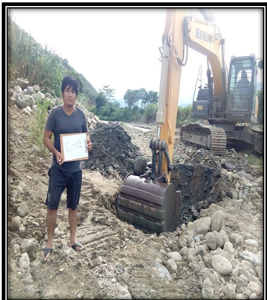
Foto N° 10: Visualización de calicata 01 - cantera Santa Rosa
