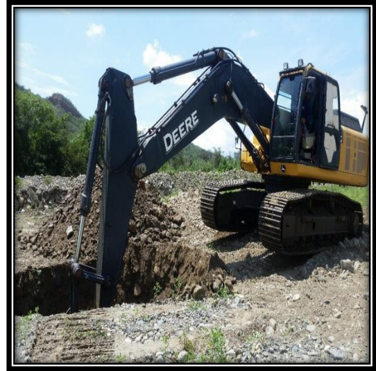
Foto N° 06: Visualización de calicata 02- cantera Arenera Jaén
