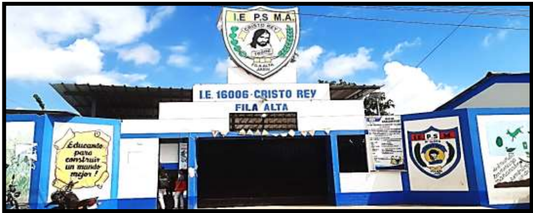
Fotografía 1 Vista parte frontal del colegio “CRISTO REY”
