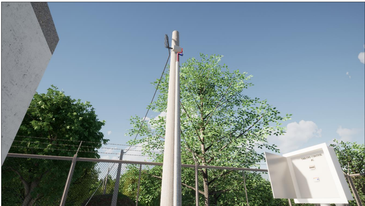
Vista tablero de control AC y soporte de salida a distribución
