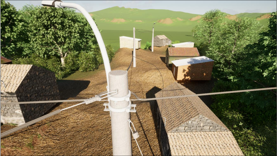
Vista aérea del armado del sistema de distribución.
