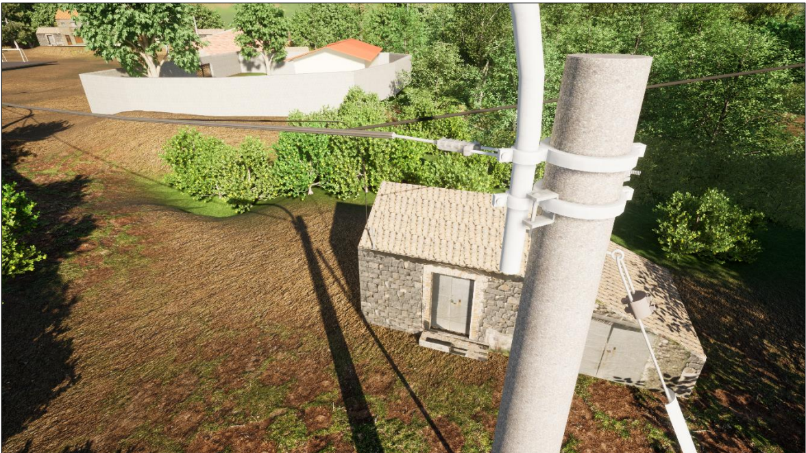
Vista aérea del armado del sistema de distribución.
