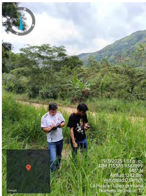
Figura 11: Toma de coordenadas de trazo de ruta para la línea primaria
