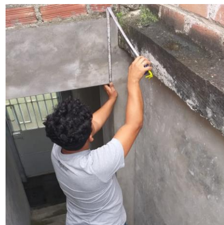
Figura 10. Medición de sección de viga en vivienda ubicada en calle Los Chasquis N° 207.
