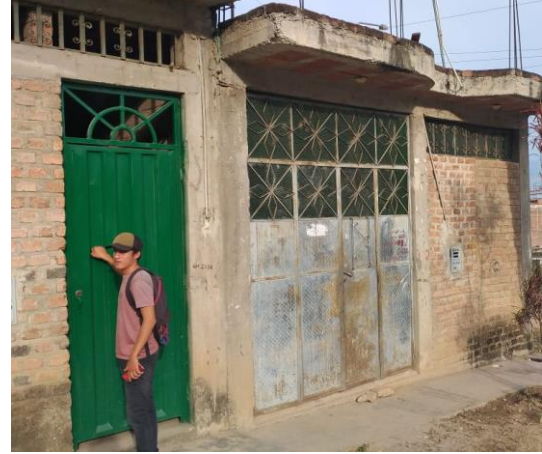
Figura 4. Identificación de vivienda ubicada en la calle Unión N° 1151.
