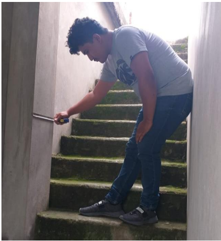
Figura 7. Medición de sección de columna en vivienda ubicada en la calle Los Chasquis N° 207
