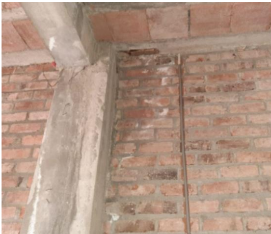
Figura 27. Sección de columnas y vigas diferentes observado en vivienda ubicada en la calle Los Incas Cuadra N° 1.
