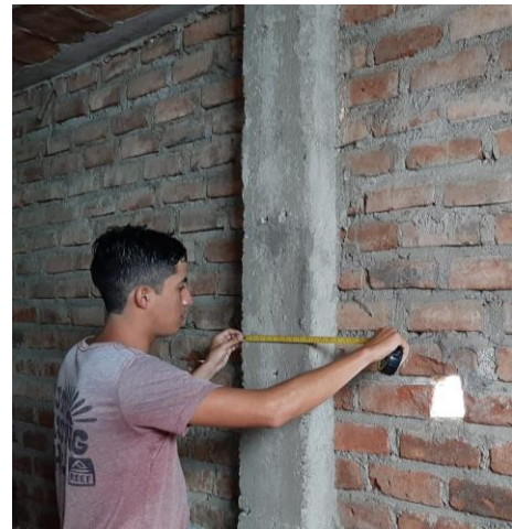
Figura 8. Medición de sección de columna en vivienda ubicada en la calle Los Incas N° 121.
