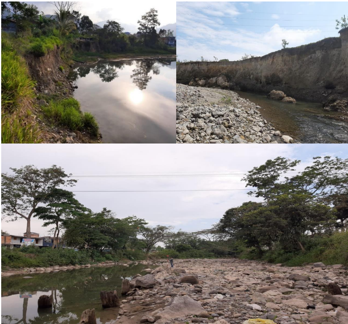
Figura: 51. Planicies de inundación margen derecha, tomadas en cuenta para determinar el coeficiente de Manning
