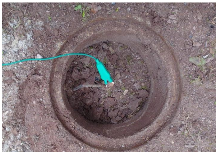
Figura 4 Verificación en campo de equipos eléctricos durante el proceso de inventario
