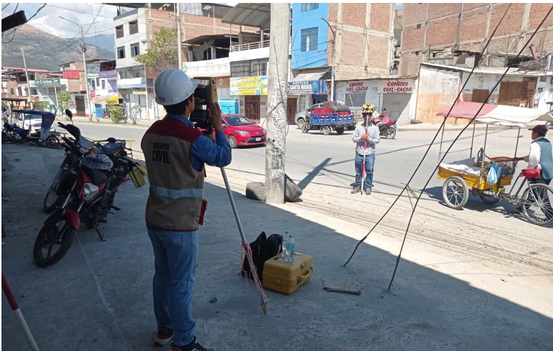
Levantamiento topográfico del óvalo binacional
