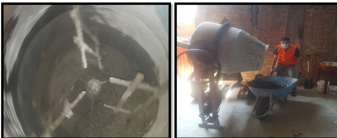
MEZCLADO DE LOS MATERIALES PARA LA PRODUCCIÓN DE CONCRETO
