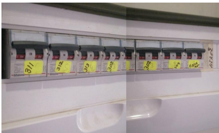
Figura 29. Tablero cuarto piso
