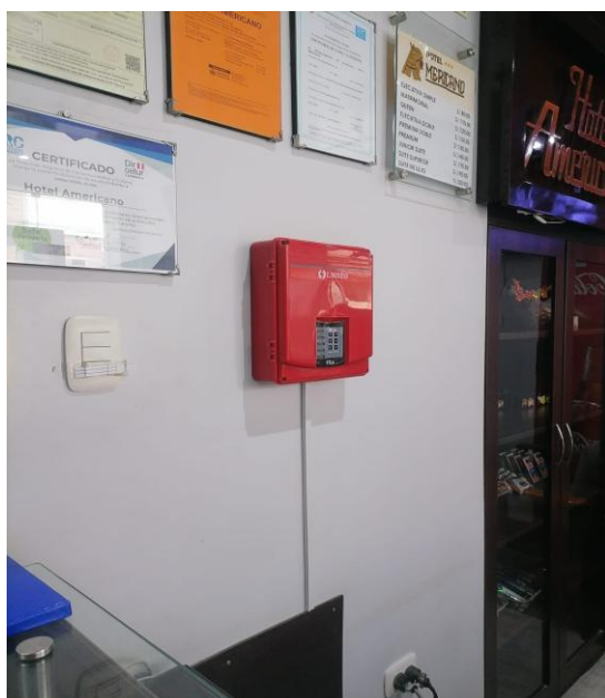
Central de alarma contra incendio LINSEG – FX4
