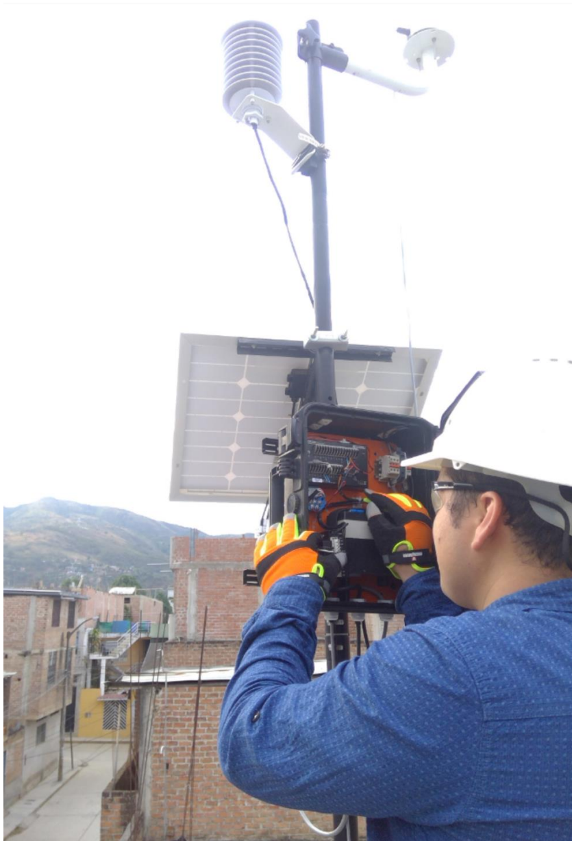
Figura 39. Montaje de caja y cableado de sensores.
