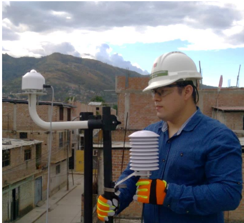
Figura 38. Montaje de sensor de temperatura.
