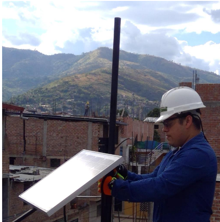
Figura 35. Montaje de panel solar de 50W.
