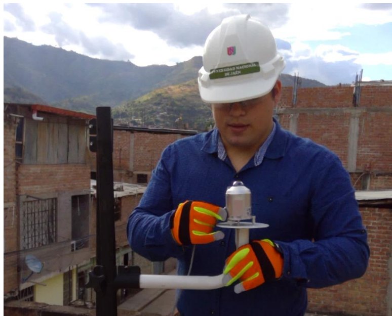
Figura 36. Montaje del piranómetro.
