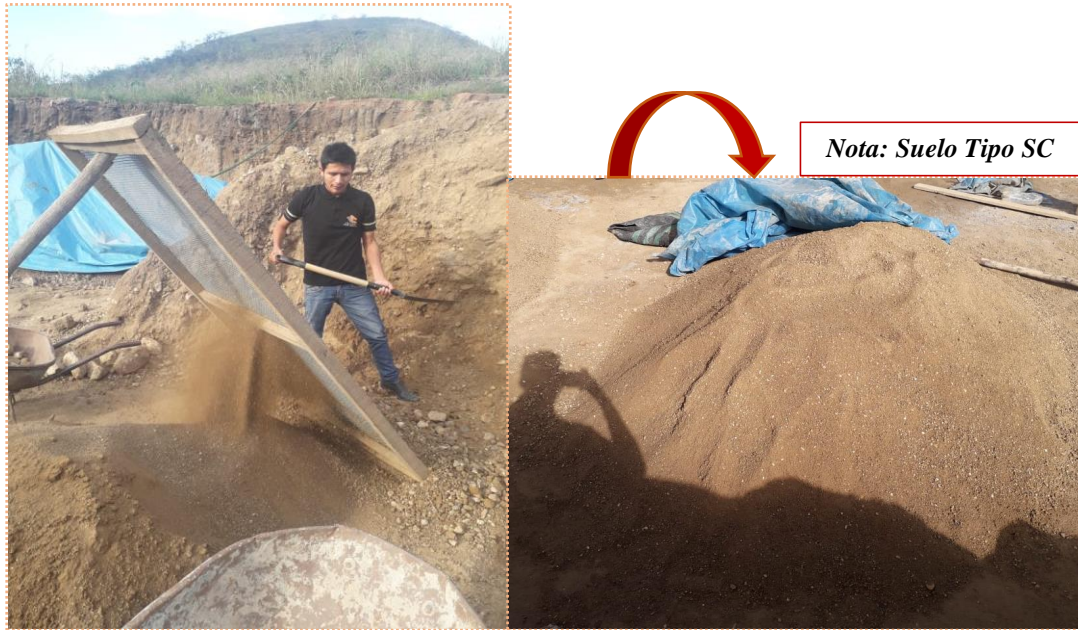
Figura 76. Proceso de tamizaje de suelo a emplearse en la elaboración de ladrillos utilizando zaranda de 3/8”.
