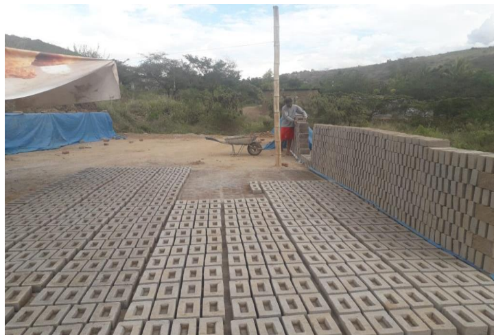
Figura 20. Secado de las unidades de albañilería.
