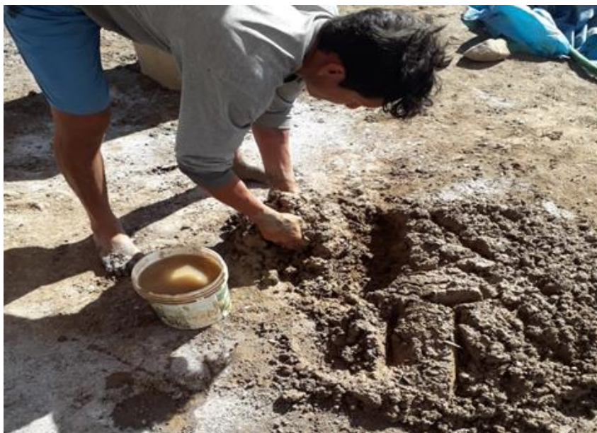
Figura 18. Tierra zarandeada para su respectiva elaboración de unidades de albañilería.
