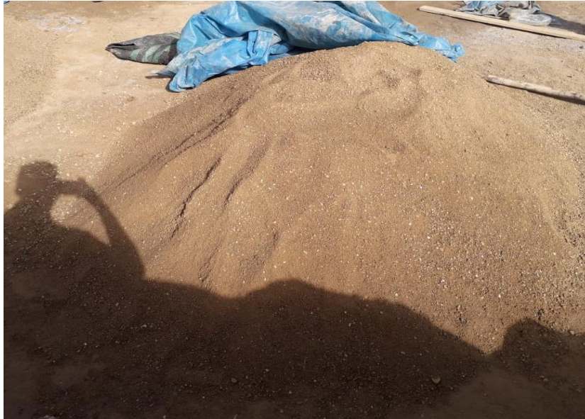
Figura 17. Tierra zarandeada para su respectiva elaboración de unidades de albañilería.
