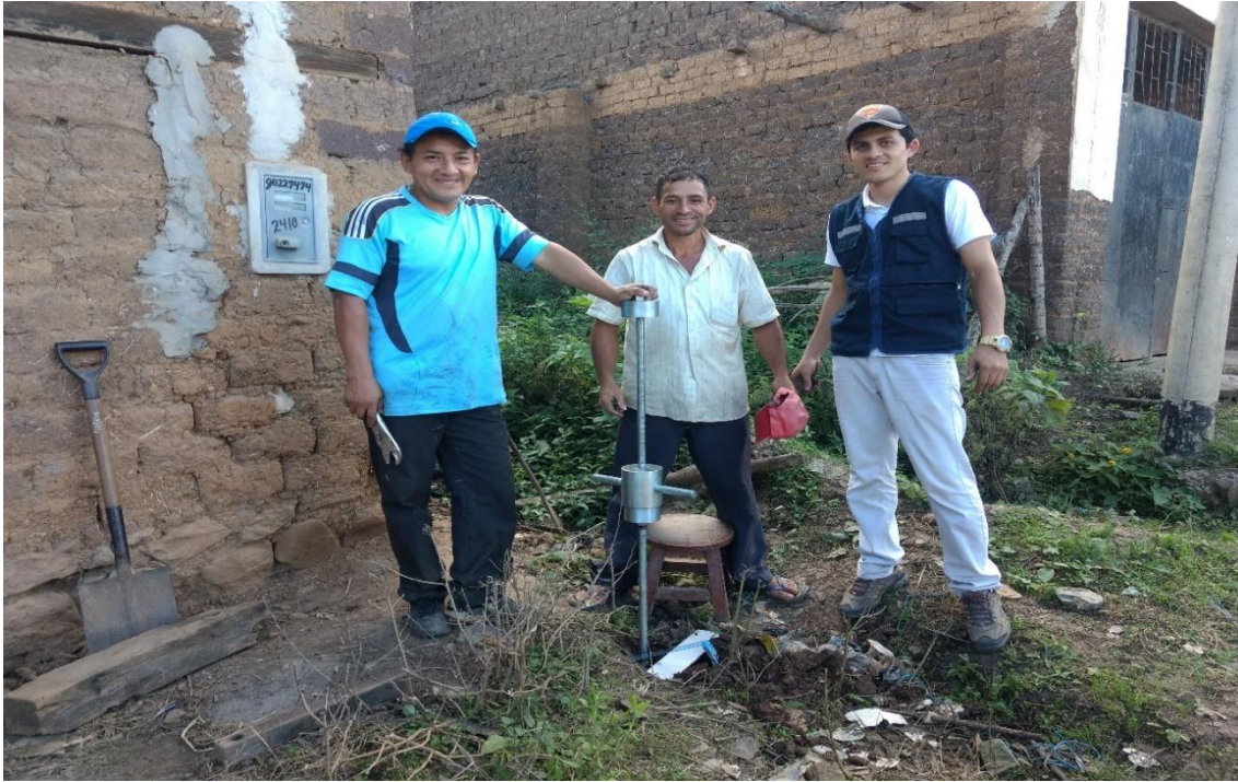
Fotografía 1: Vivienda N°06, Ensayo de Penetración Dinámica Ligera DPL-06.
