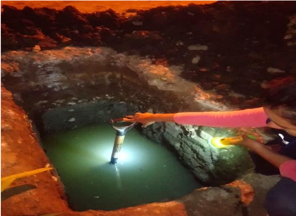
Fotografía 41: Vivienda N°12, el nivel que llegó el agua después de 12 horas de haber hecho la calicata es de 40 cm.
