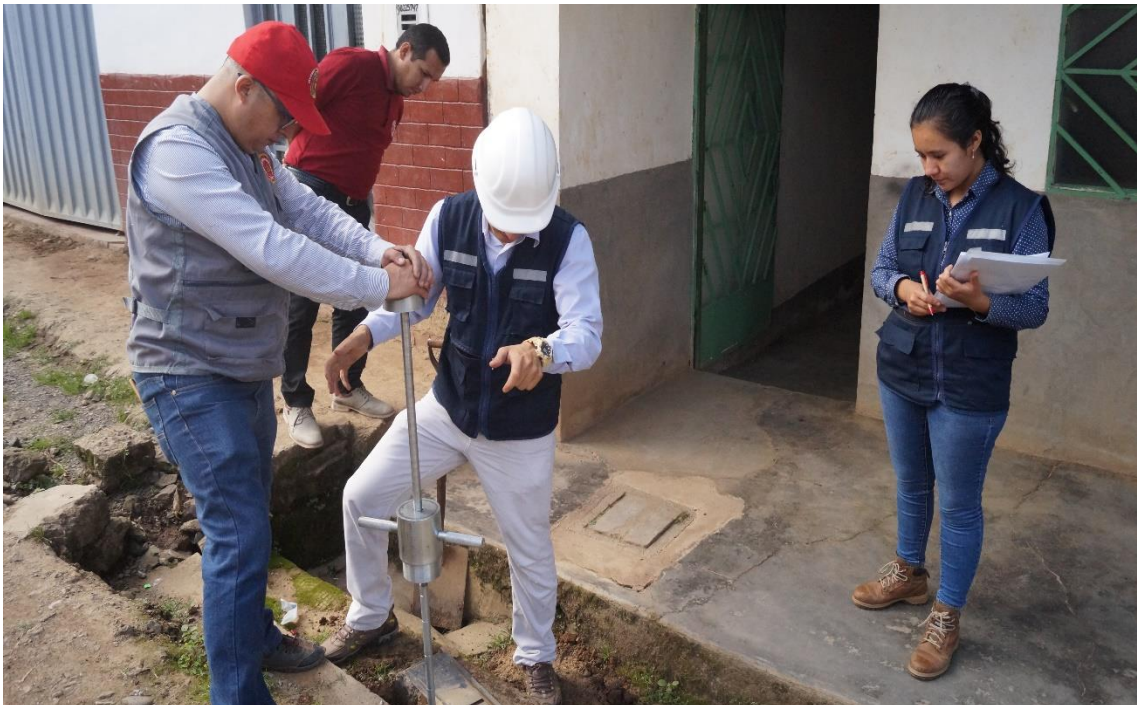
Fotografía 4: Vivienda N°11, Ensayo de Penetración Dinámica Ligera DPL-11
