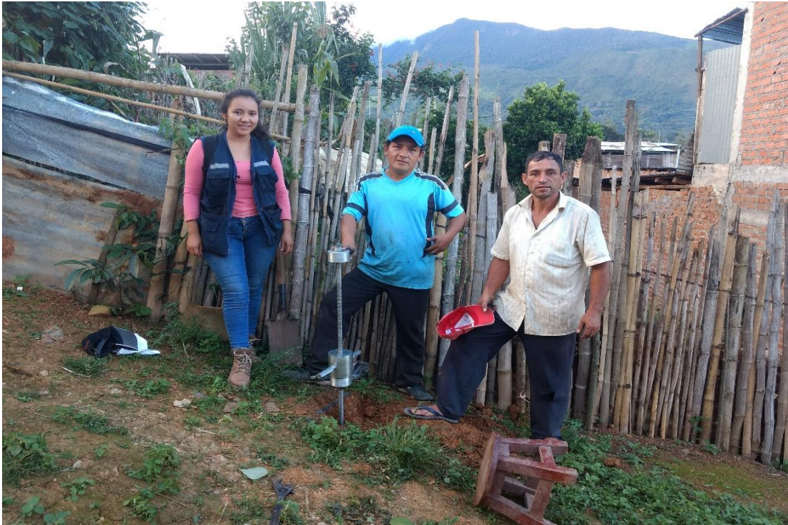
Fotografía 3: Vivienda N°11, Ensayo de Penetración Dinámica Ligera DPL-11
