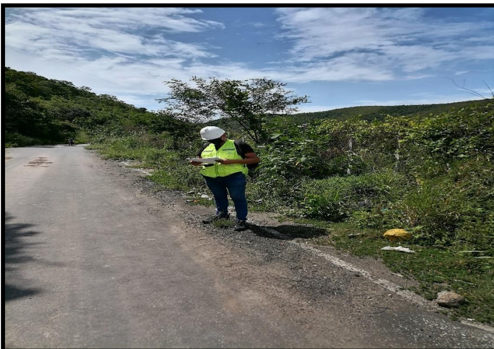
Figura 17: Hinchamiento de severidad M
