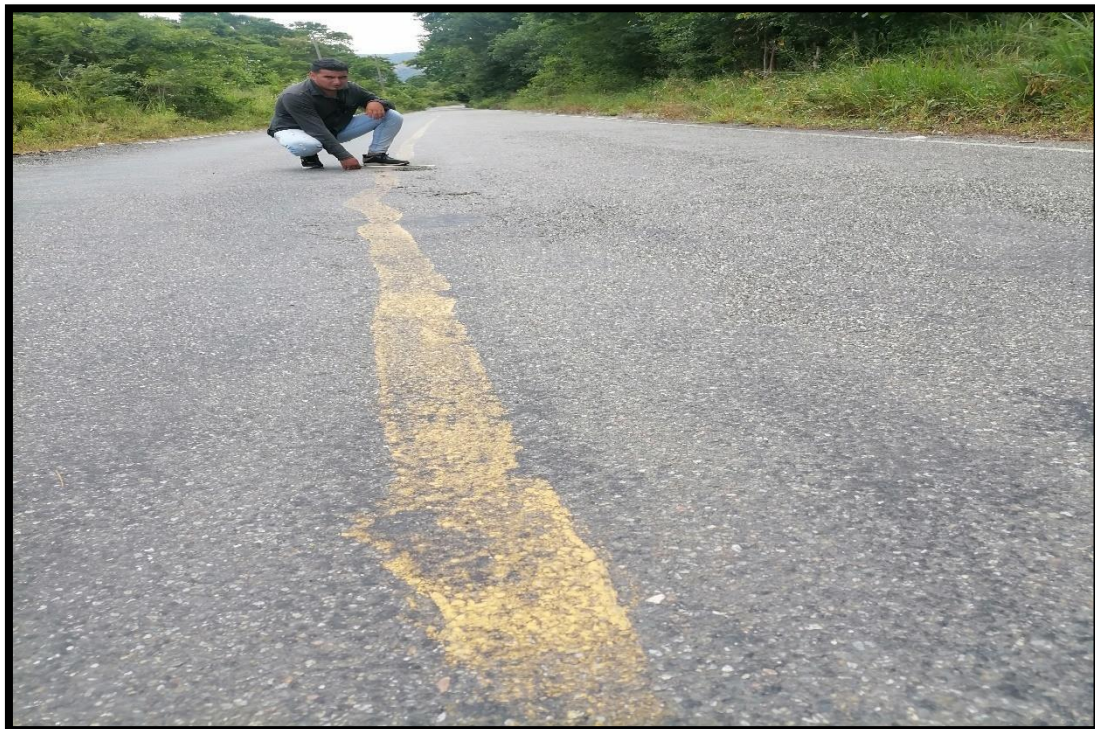
Figura 51: Unidad de muestra – 12. Hinchamiento
