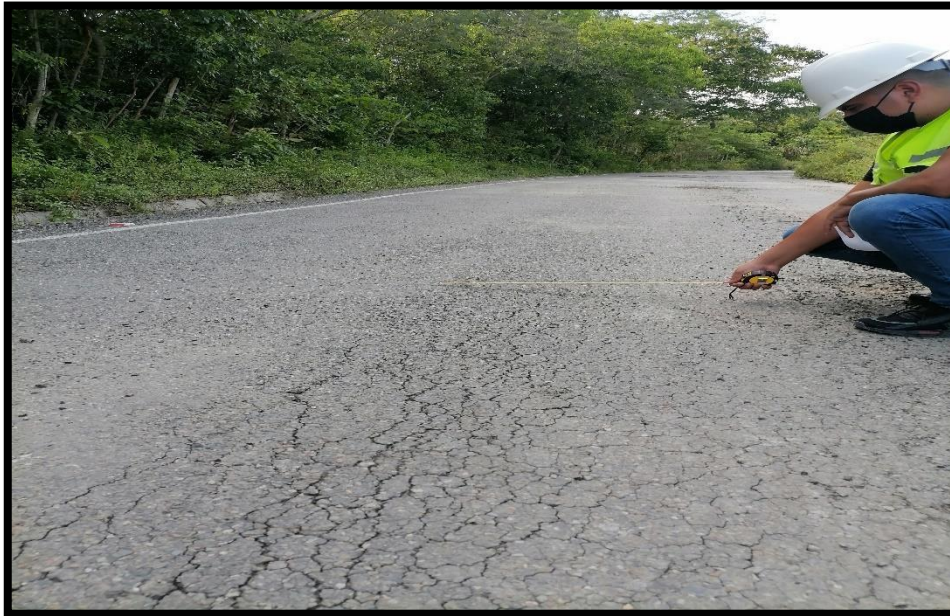
Figura 10: Depresión de severidad M
