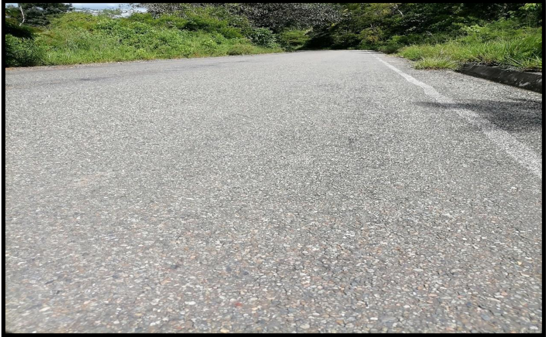
Figura 46: Unidad de muestra – 07. Pulimento de agregado.
