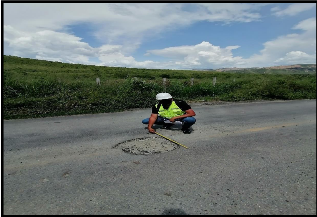
Figura 58: Unidad de muestra – 19. Huecos
