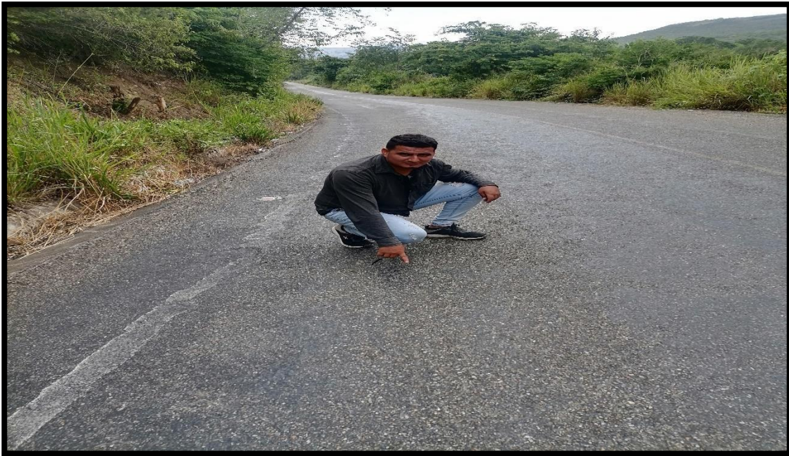
Figura 48: Unidad de muestra – 09. Pulimiento de agregados
