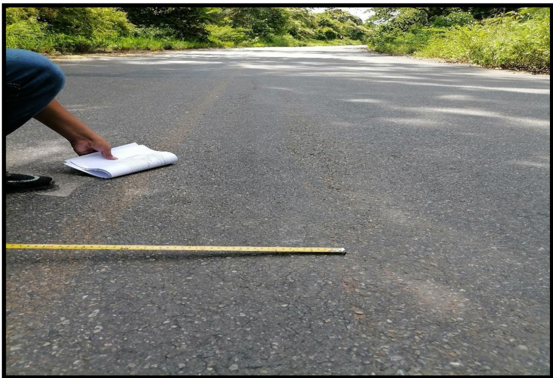
Figura 69: Unidad de muestra – 30. Piel de cocodrilo
