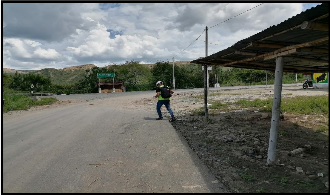
Figura 40: Unidad de muestra – 01. Fisura de borde.
