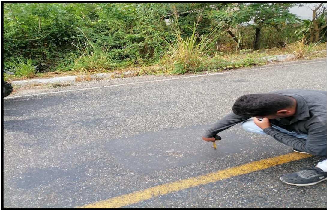
Figura 50: Unidad de muestra – 11. Parches y parches de cortes utilitarios
