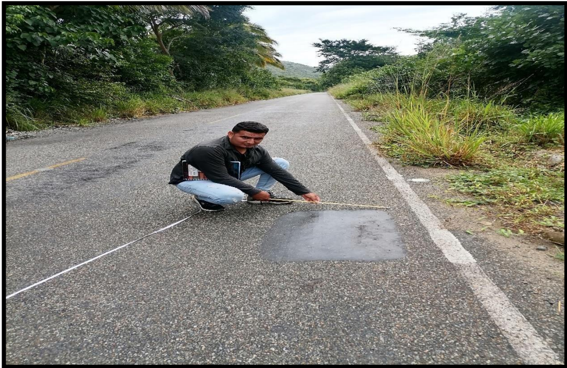
Figura 64: Unidad de muestra – 25. Parches y parches de cortes utilitarios
