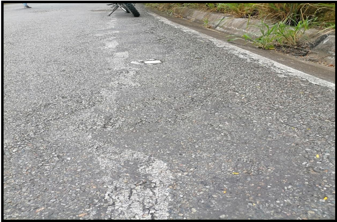
Figura 52: Unidad de muestra – 13. Depresión
