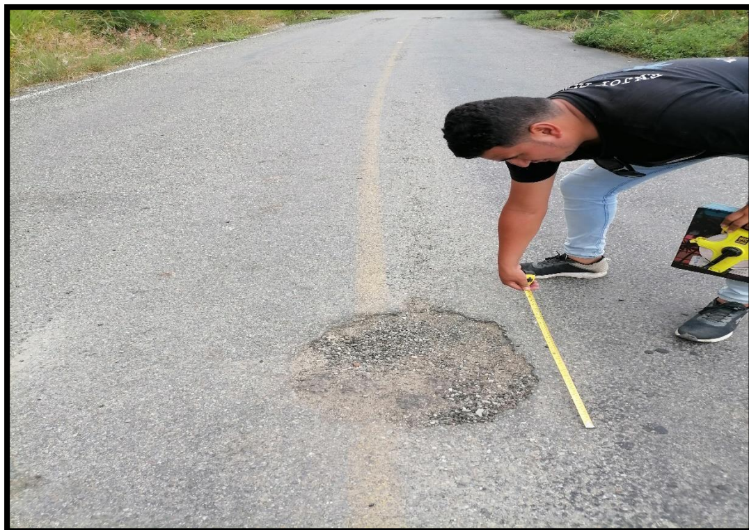
Figura 61: Unidad de muestra – 22. Huecos
