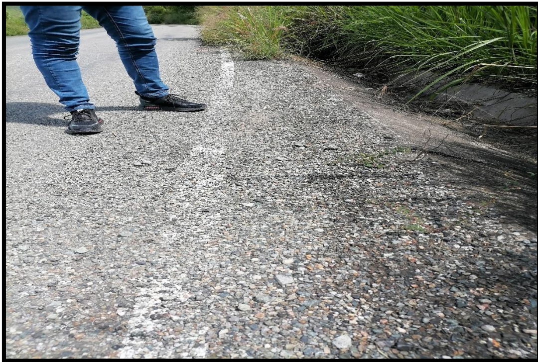
Figura 42: Unidad de muestra – 03. Pulimento de agregado.
