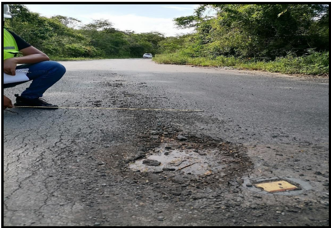
Figura 57: Unidad de muestra – 18. Huecos
