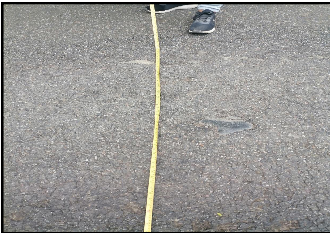
Figura 55: Unidad de muestra – 16. Piel de cocodrilo
