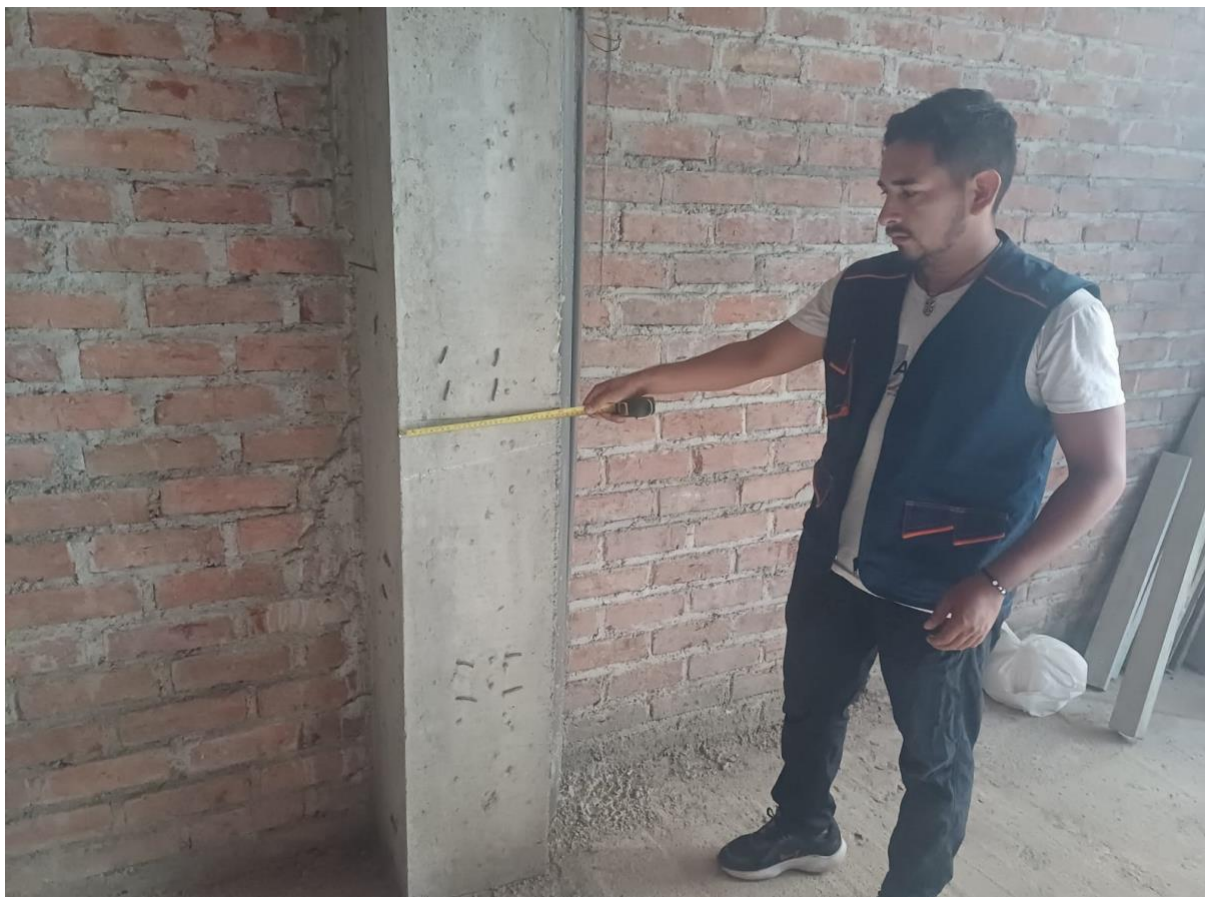
Recolección de datos vivienda 4 niveles – sector Guillermo Sánchez
