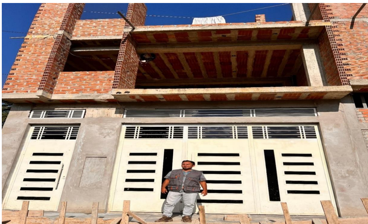
Vivienda 2 niveles – sector Guillermo Sánchez
