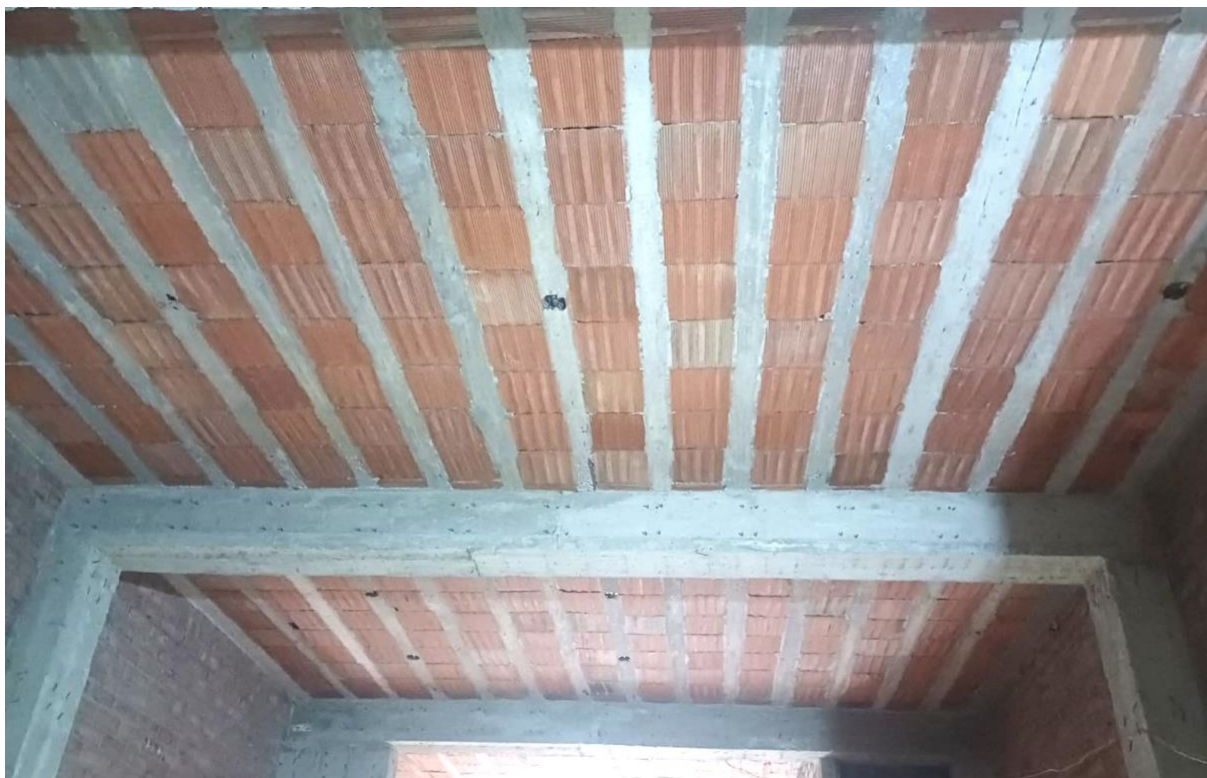
Recolección de datos vivienda 3 niveles – sector Guillermo Sánchez
