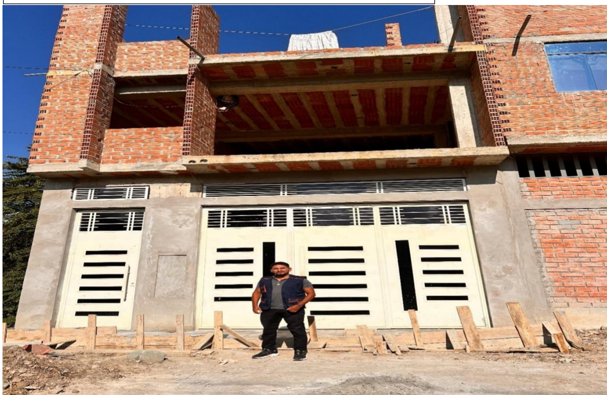
Vivienda 2 niveles – sector Guillermo Sánchez
