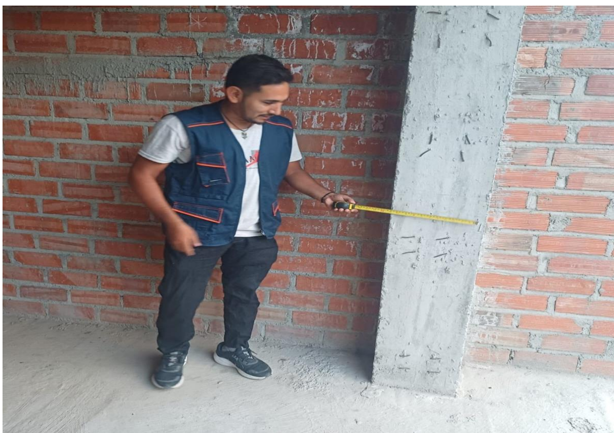
Recolección de datos vivienda 3 niveles – sector Guillermo Sánchez
