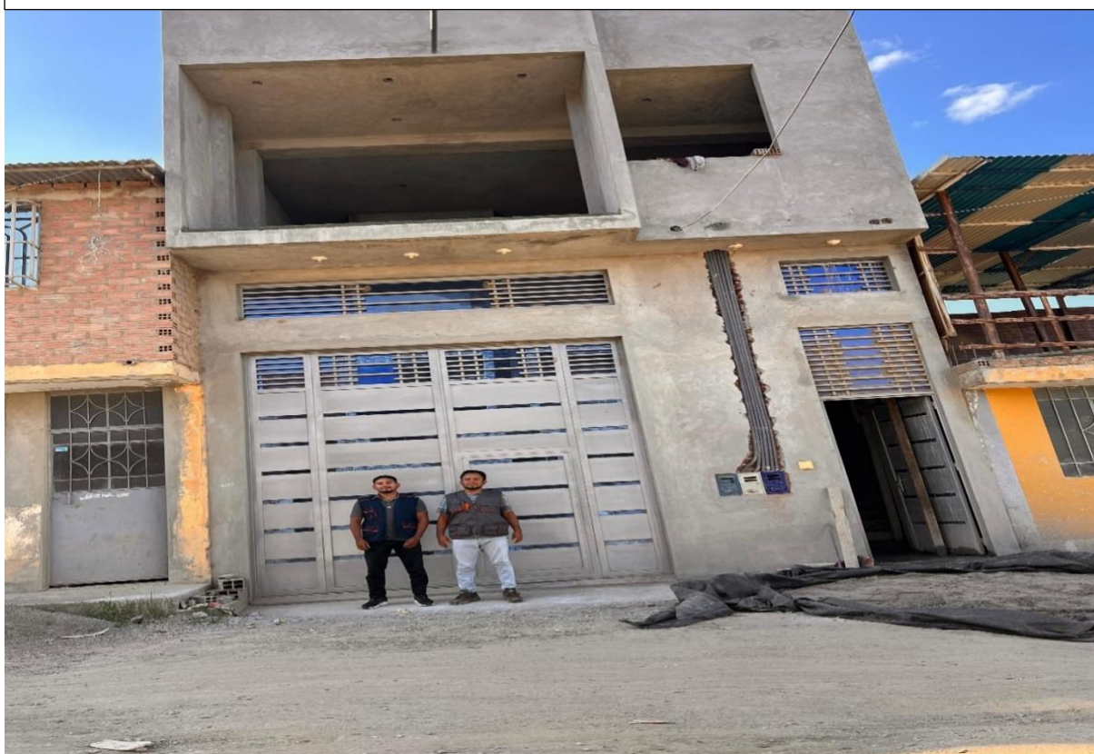
Vivienda 2 niveles – sector Guillermo Sánchez
