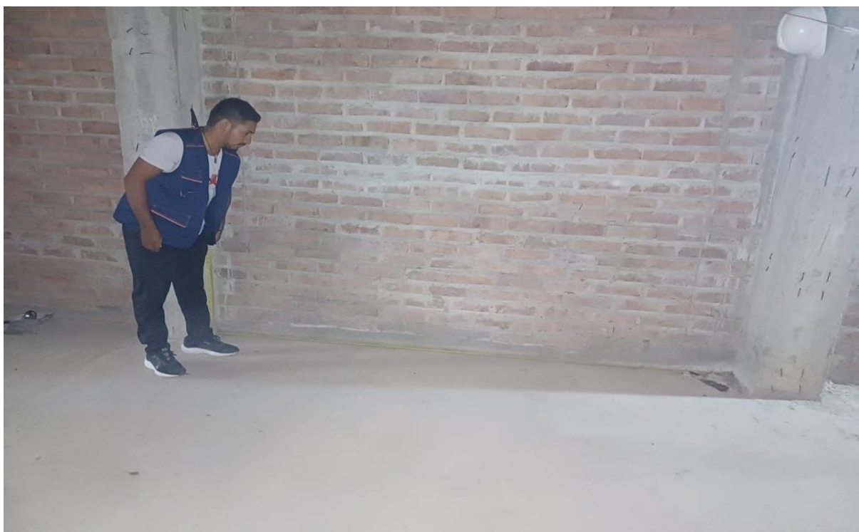
Recolección de datos vivienda 4 niveles – sector Guillermo Sánchez
