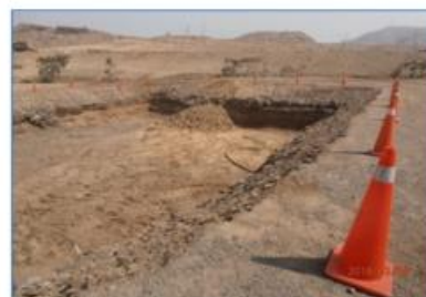
Excavación para bases de grupos
