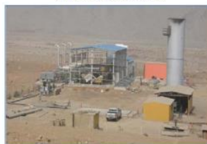
Central Termoeléctrica Huaycoloro
