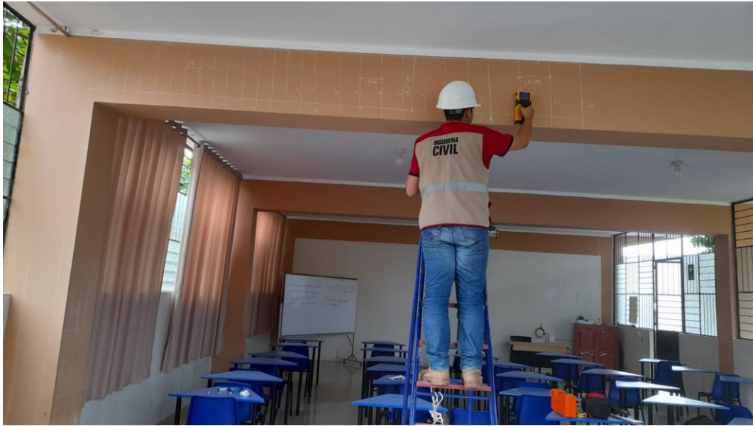
Figura 2 Detección de aceros longitudinales y transversales en vigas
