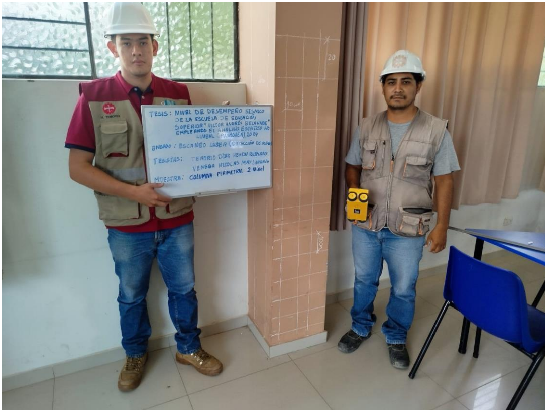
Figura 3 Detección de aceros longitudinales y transversales en columnas
