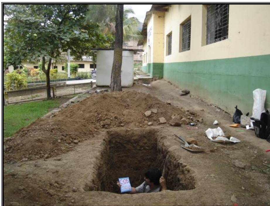
Foto N°021: Vista de C-5, en esta parte actualmente se ubican los módulos IV y VIII.
