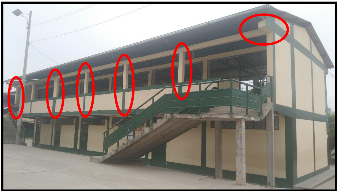
Ilustración 13: Columnetas de volado cumplen funciones de soporte y transmisión de cargas, en los módulos IV y VIII.
