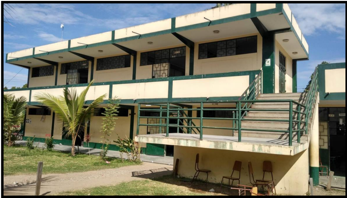
Ilustración 18: Diafragmas, vigas, columnas y columnetas de concreto armado, en el módulo VI.
