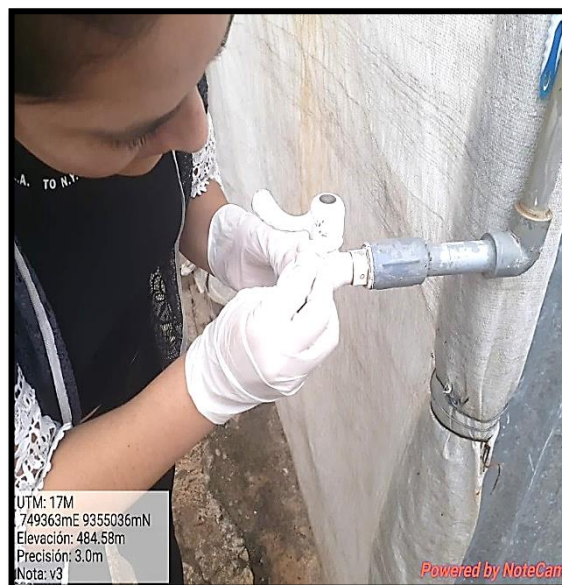
Foto 04: Desinfección del grifo domiciliario N° 3.
