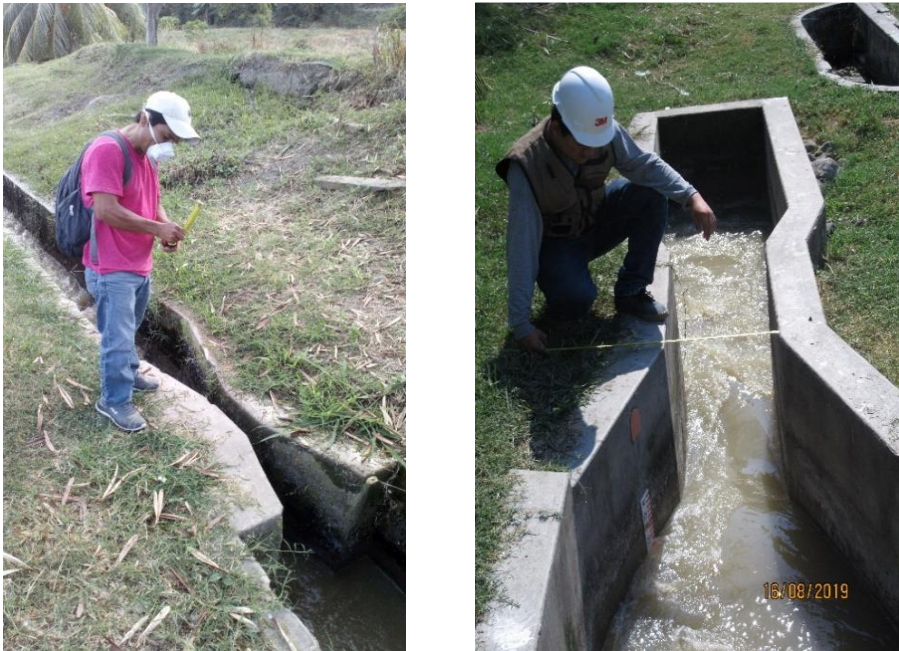
Figura N° 7. Aforadores Parshall de ambas lagunas.
