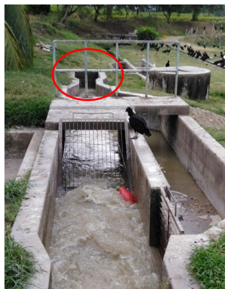
Imagen N° 3. Medidores Parshall en buen estado.
