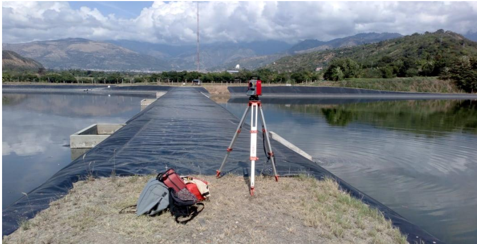
Figura N° 22. Levantamiento topográfico de PTAR de Jaén.
