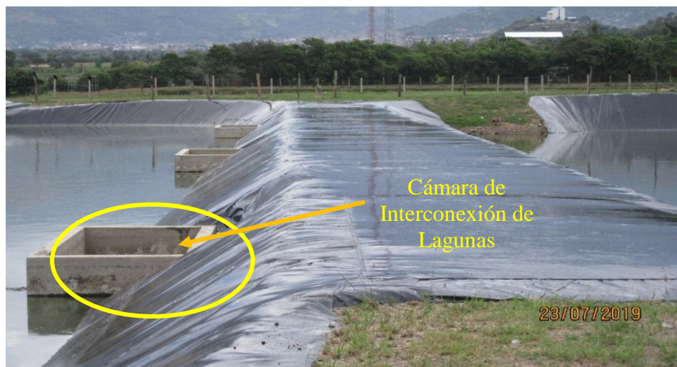
Figura N° 18. Laguna Anaeróbica con estructuras de Concreto para interconexiones.
