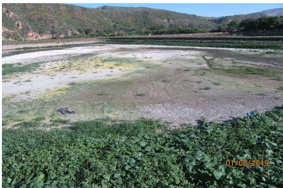
Figura N° 37. Laguna anaerobia primaria
