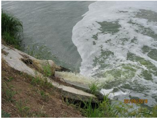
Imagen N° 7. Flujo sobre la Superficie Lagunar Provocando Cortocircuitos Hidráulicos
