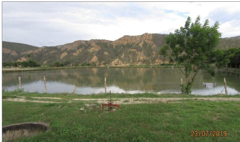
Figura N° 14. Laguna de Estabilización Anaeróbica N°1 Antigua.
