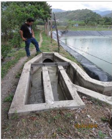
Imagen N° 3. Medidores Parshall en buen estado.
