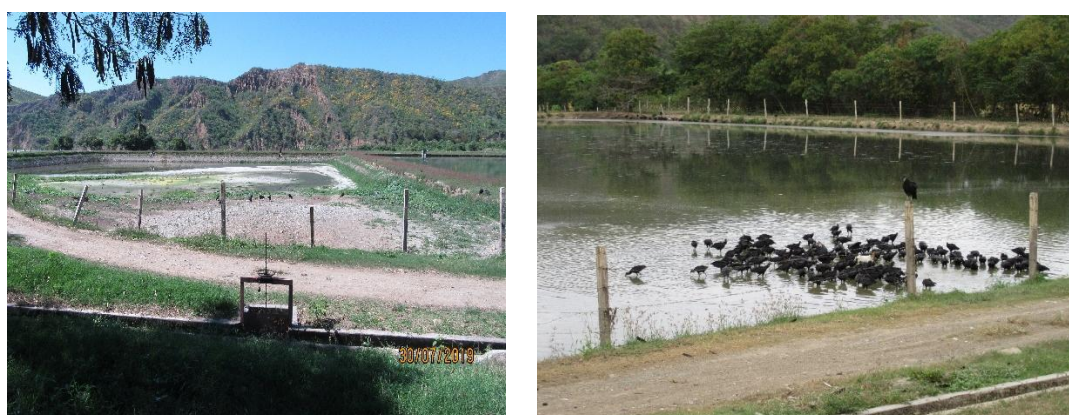
Imagen N° 12. Lagunas Antiguas Primarias Colmatadas.
