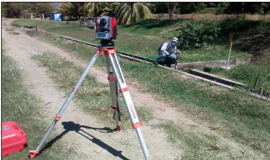
Figura N° 23. Levantamiento topográfico de PTAR de Jaén.
