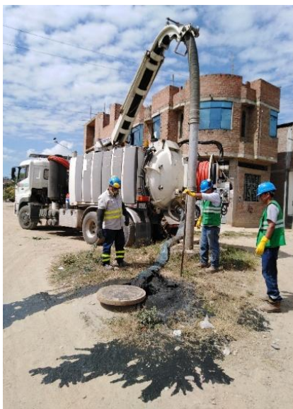
Figura N° 41. Hidrojet desatorando las redes de desagüe.
