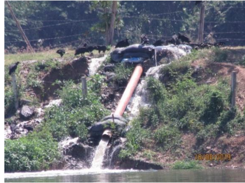
Imagen N° 7. Flujo sobre la Superficie Lagunar Provocando Cortocircuitos Hidráulicos
