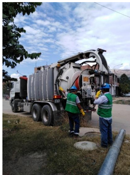
Figura N° 41. Hidrojet desatorando las redes de desagüe.
