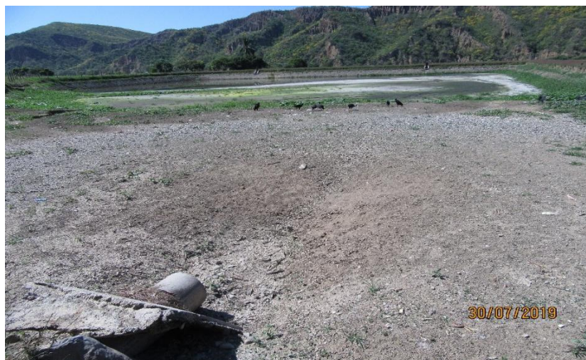
Figura N° 16. Laguna de oxidación anaerobia Antigua N°2 en mantenimiento.
