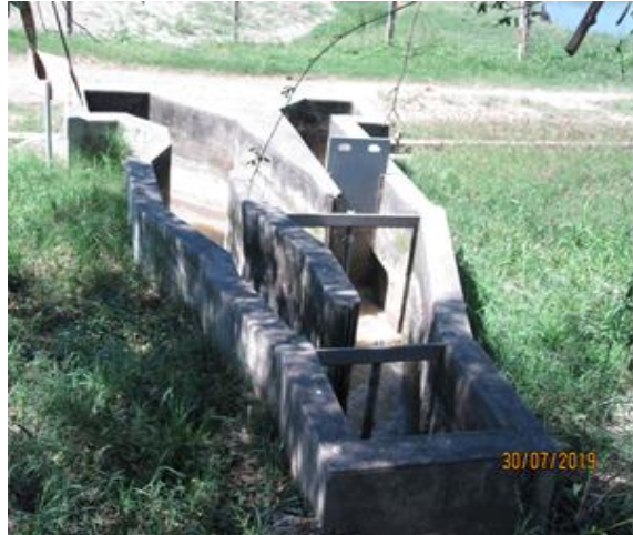
Imagen N° 3. Medidores Parshall en buen estado.
