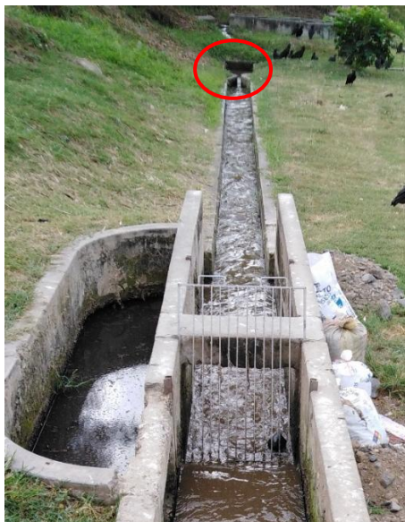
Imagen N° 3. Medidores Parshall en buen estado.
