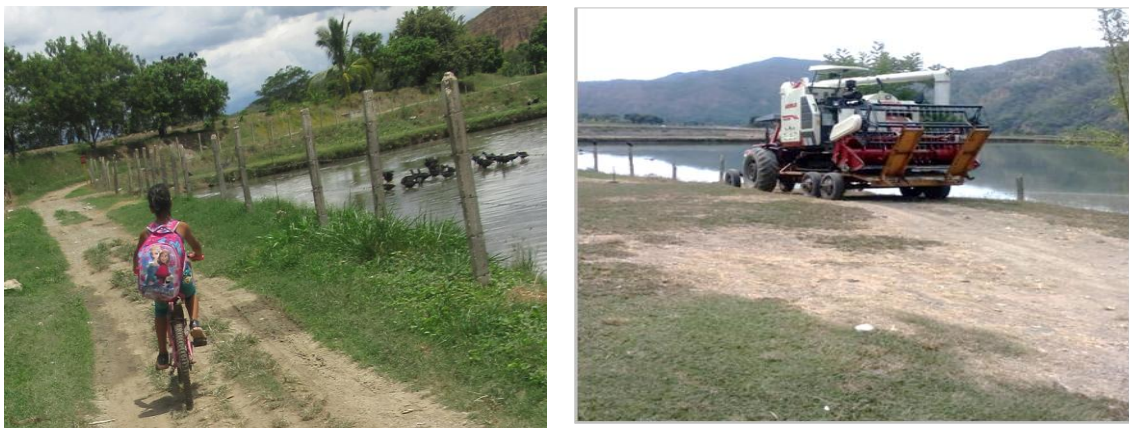
Figura N° 42. Lagunas de oxidación sin señales reglamentarias.
