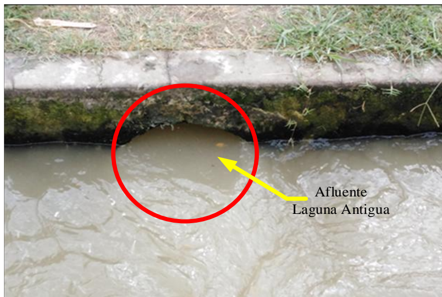
Figura N° 39. Afluente de la Laguna Antigua recibiendo exceso de caudales.
