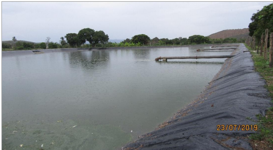
Figura N° 17. Laguna de Estabilización Anaerobia N° 3
