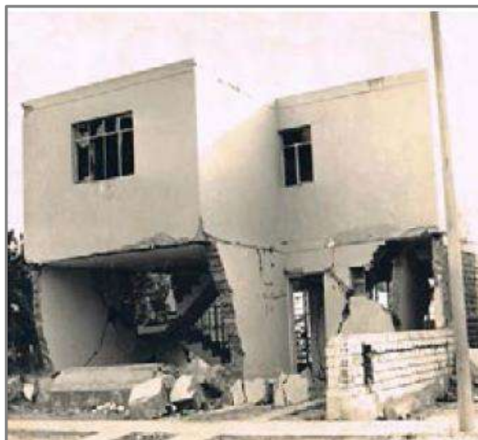
Figura 7. Vivienda de albañilería, Chimote Sur, 31. May.1970, con poca rigidez (muy flexible) y escasa resistencia en la dirección paralela a las fachadas.
