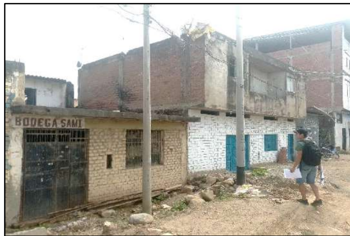
Figura 43. Identificación del estado de la vivienda de albañilería
