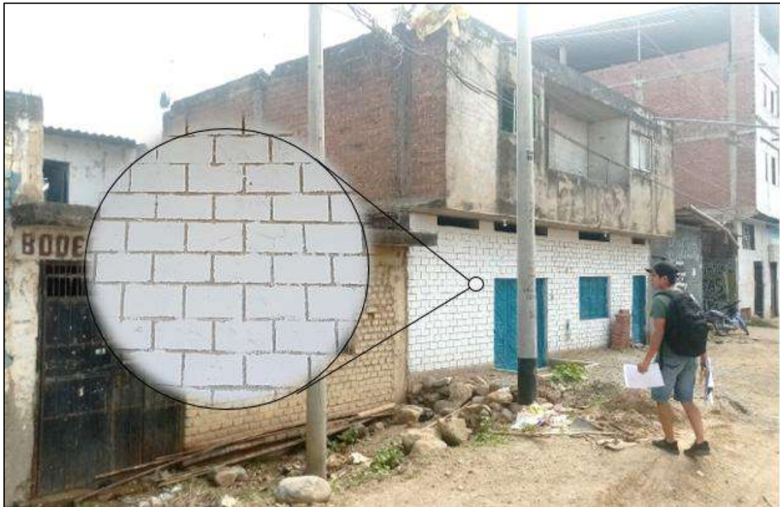
Figura 12. Vivienda de albañilería con espesor de juntas adecuada en muros.
