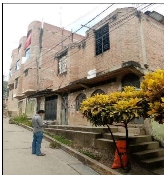
Figura 42. Identificación de viviendas de albañilería.
