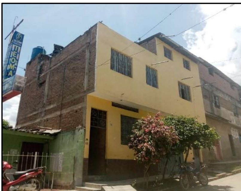
Figura 72. Edificación de albañilería ubicada en la Collasuyo; en la cual se aprecia la separación de muros de L = 3.70\text{m} , y el espesor del muro S=0.25\text{m} , teniendo L/S=14.8 . Por lo que L/S < 15 mayor, entonces para este parámetro le corresponde la letra A.
