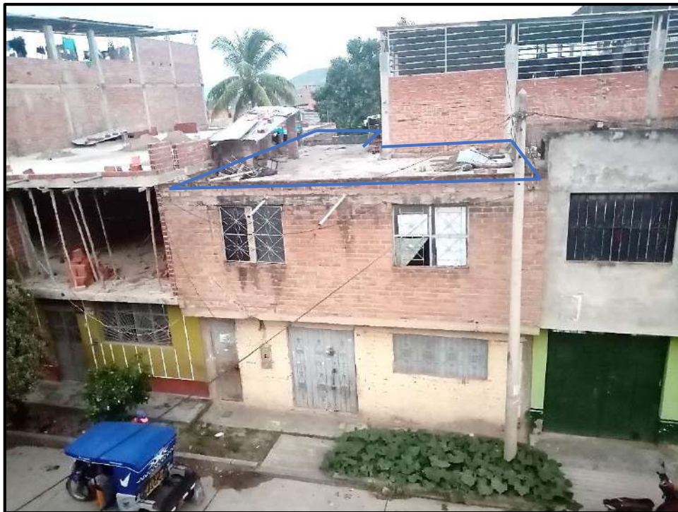
Figura 70. Vivienda de albañilería ubicada en la Calle Inti Raymi; edificación que presenta irregularidad en planta por esquinas entrantes.
