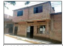
Vivienda de albañilería ubicada en la calle 4 de junio (sector pueblo libre, manzana 55, lote 53). VULNERABILIDAD MEDIA
