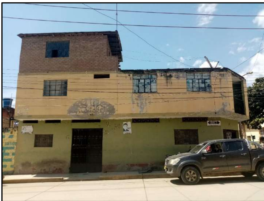
Figura 64. Edificaciones de Albañilería ubicada en Calle Coricancha, con deficiencias en confinamiento, en el tercer piso no presenta elementos de arriostre ya sea viga y columnas.
