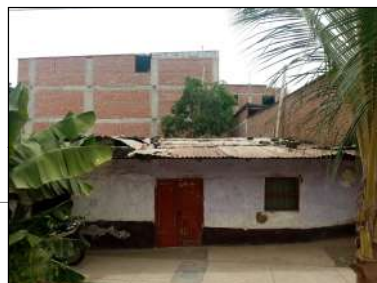
Vivienda de albañilería ubicada en la calle Pardo Miguel (sector pueblo libre, manzana 28, lote 23)
