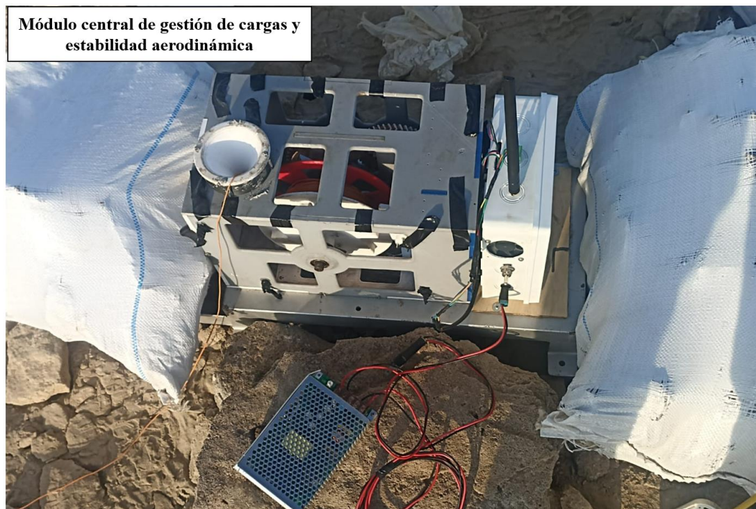
Instalación final del módulo central
