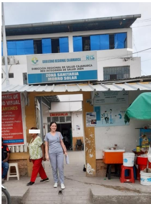
Foto 1: Fachada de Centro de Salud Morro Solar
