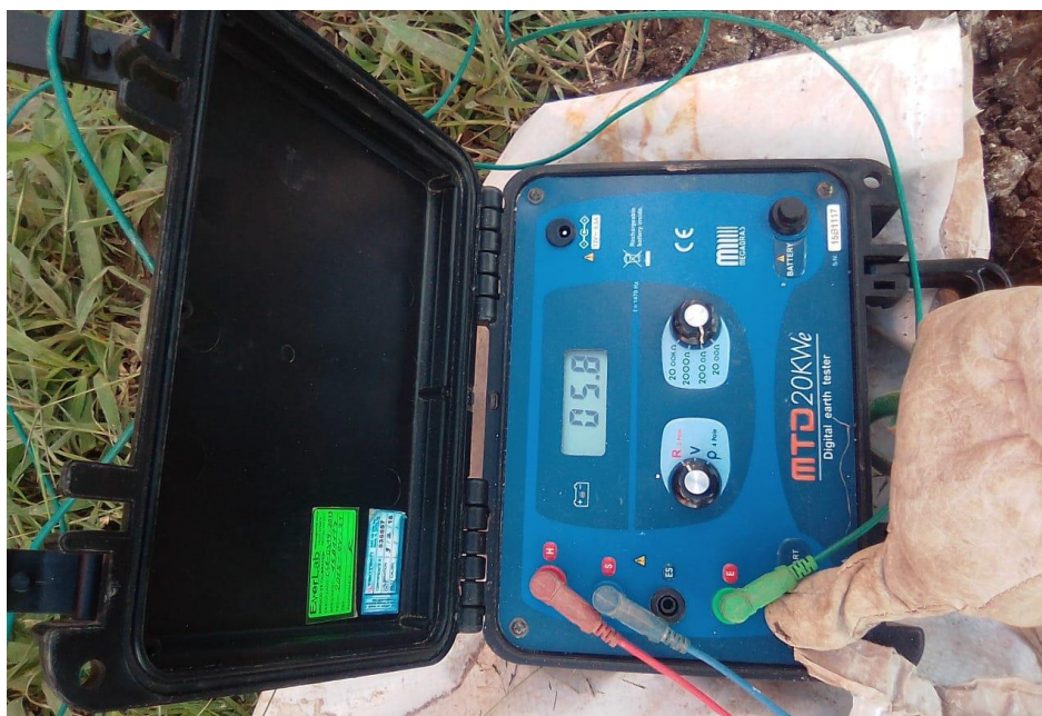
FIGURA N°23 Instalación de un pozo a tierra
