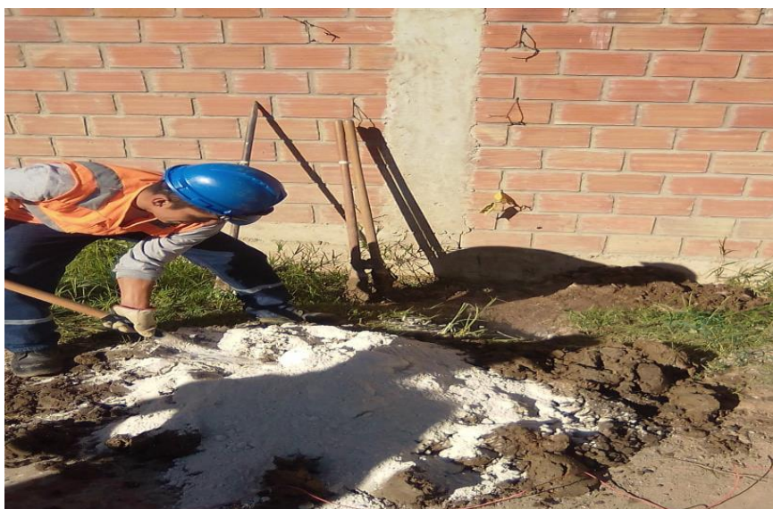
FIGURA N°22 Instalación de pozo a tierra para las viviendas
