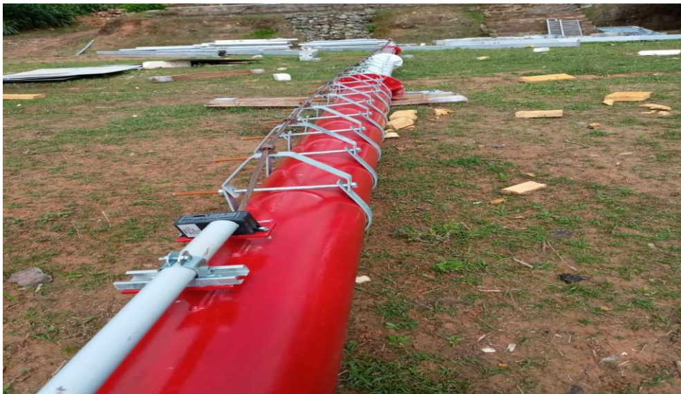
FIGURA N°20 : Pararrayo Franklin de 10 mts de altura.
