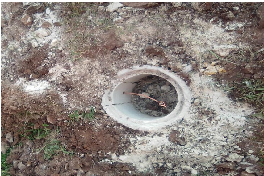
FIGURA N°21 Instalación de pozo a tierra
