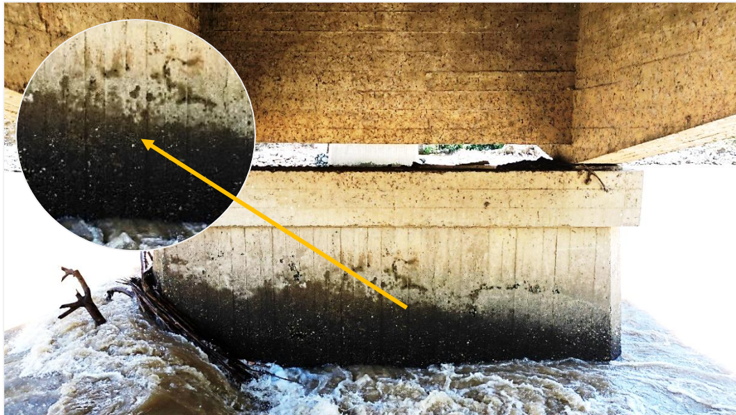
Apoyos del Puente Tamborapa
