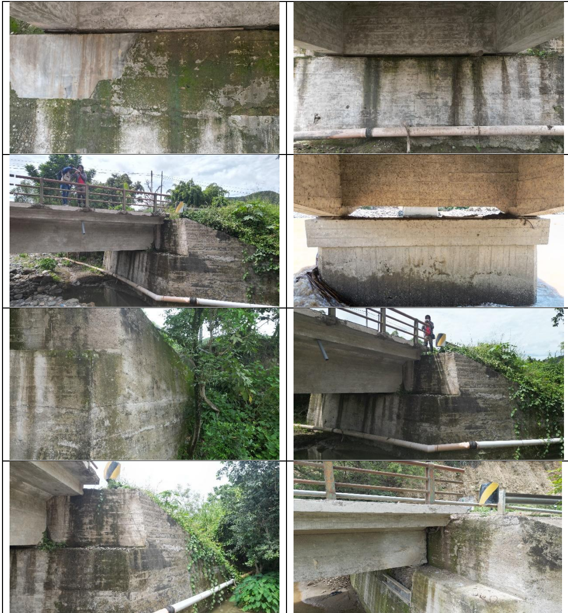
Anexo 6: Evaluación de daños de desplazamientos.
