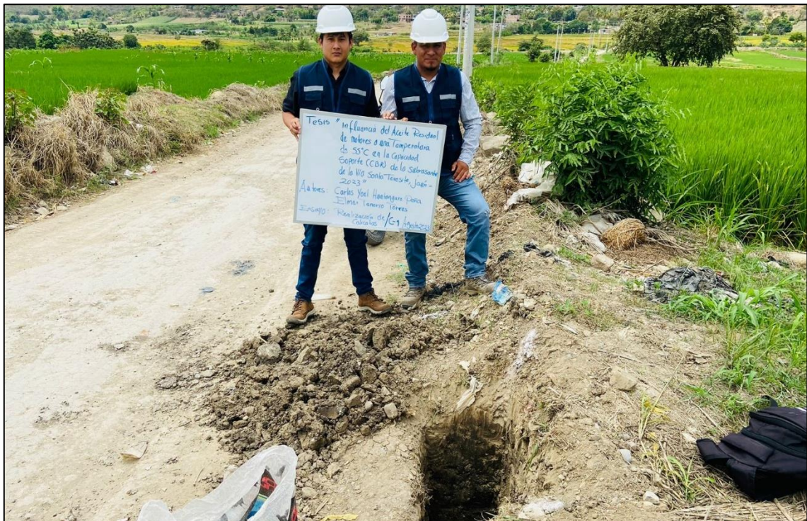
Realización de calicata C-1
